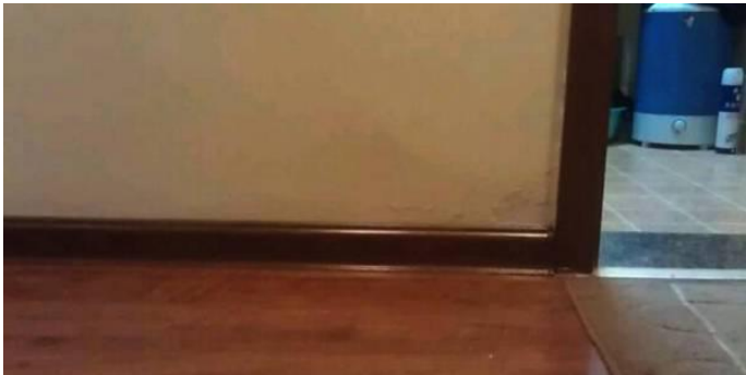
③门套的两边，也建议多涂 20-30cm 的防水，一定程度上可以减少门套返潮。
